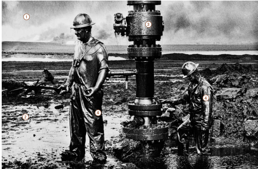
Gisement de pétrole du grand Burhan, Koweït, 1991. Mise en place d'une nouvelle tête de puits © Sebastião Salgado / Amazonas Images
